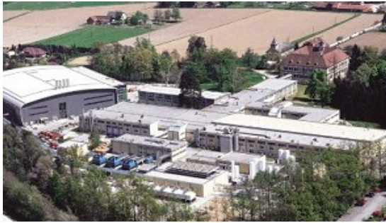
Luftaufnahme Fab- & Bürogebäude
